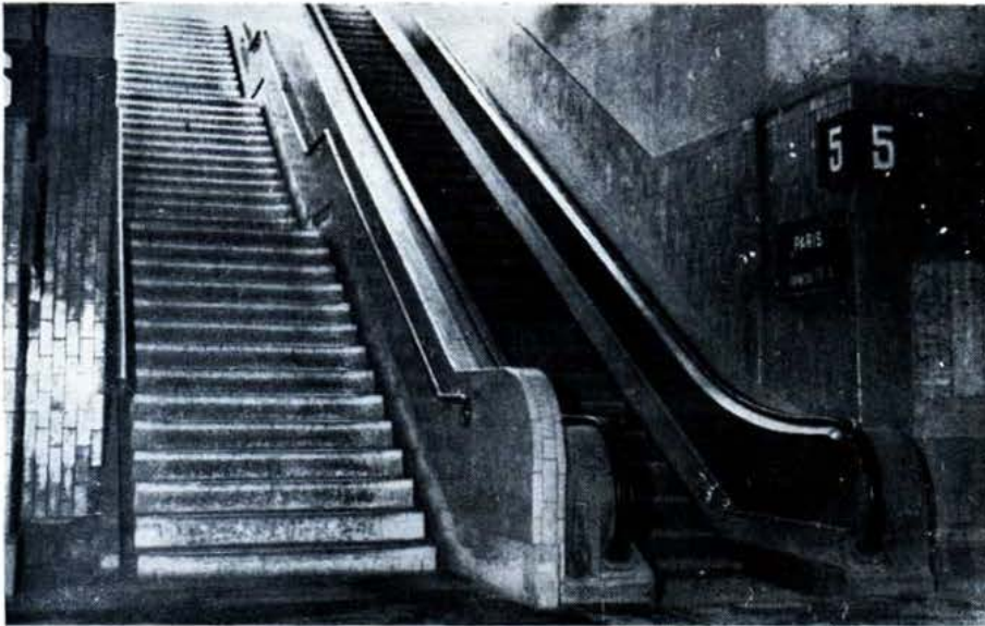
Escalier d'accès aux quais.
