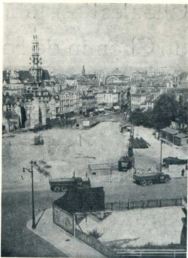
Vue des travaux en cours.
