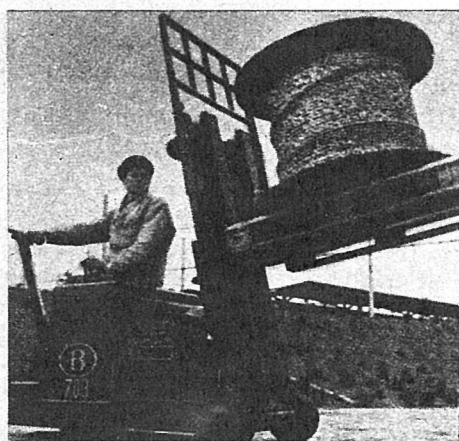
ELEKTRISCH VORKHEFWAGENTJE, MET DIESEL, GEVOED DOOR BATTERIJEN (N° 701 TOT 705). Snelheid : 3 km/h. Gewicht : 2.500 kg. Nuttige last : 1.200 kg. Hefhoogte : 2 m 30. Het is krachtiger maar niet zo snel als het voorgaande.
