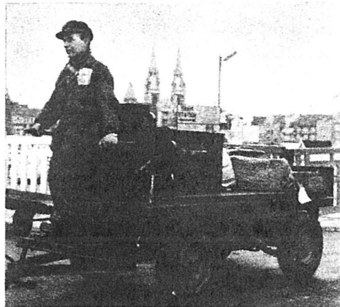
VIERWIELIGE ELEKTRISCHE TRACTOR MET LAADBORD (N° 401 TOT 404). Gewicht : 1.200 en 1.700 kg. Hij kan vrachten vervoeren op zijn laadbord en driewielers slepen. Nuttige last : 1.500 kg.
