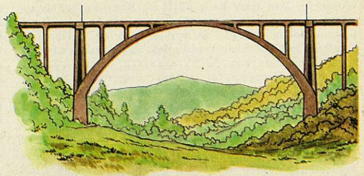
Brug van Langwies, Zwitserland (gewapend beton).
