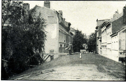
Estrados du pont de la rue de La Fontaine (1914). (Cliché Franchimont.)
