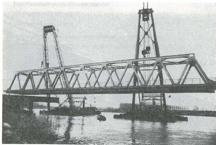
Het middenste gedeelte van de nieuwe spoorwegbrug over de Schelde te Dendermonde tijdens het plaatsen tussen de twee vaste brugdekken.
