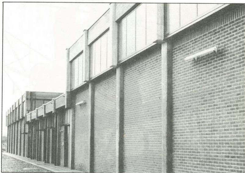
Nieuw Tractie-Onderstation in Heist-op-den-Berg
