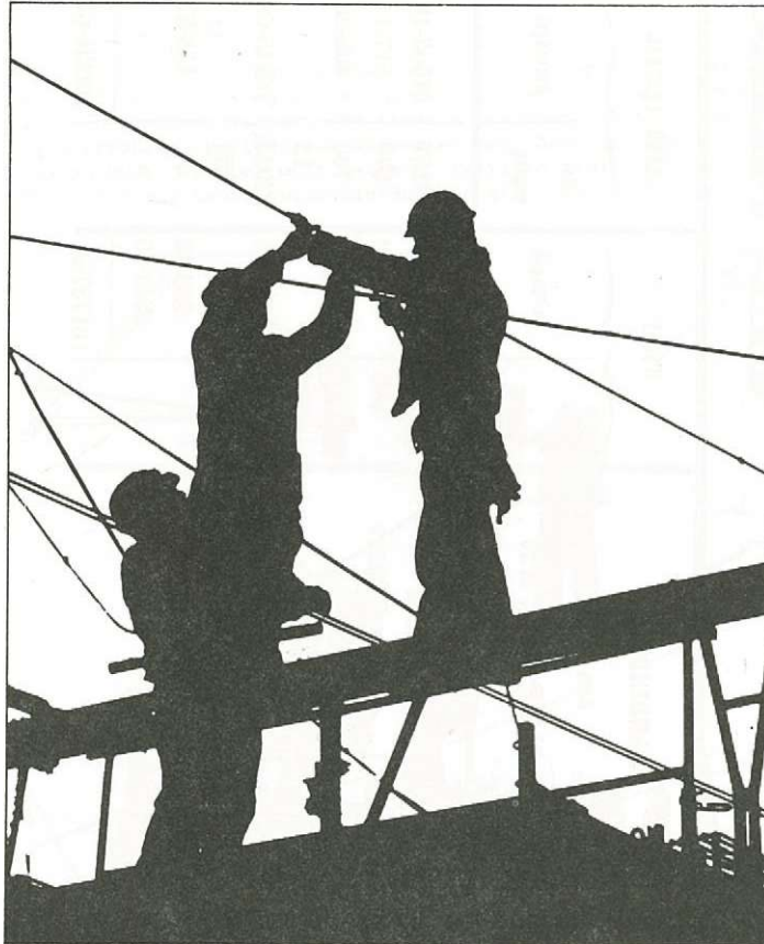
Het spannen van de bovenleiding
