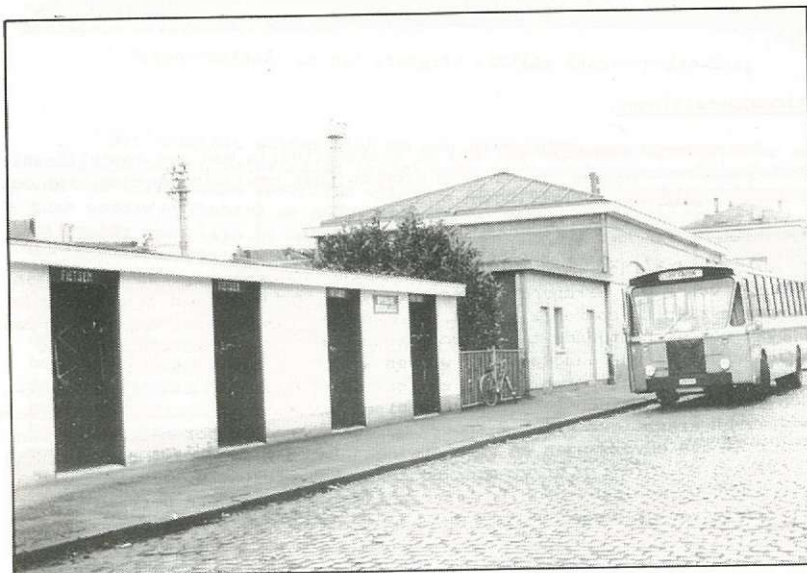
Nieuwe fietsenstalling in station Lier
