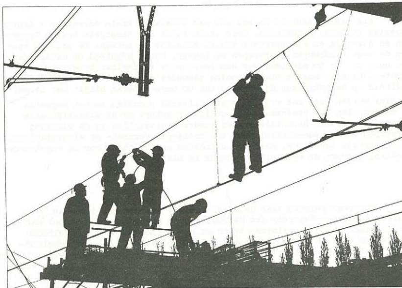
Het spannen van de bovenleiding
