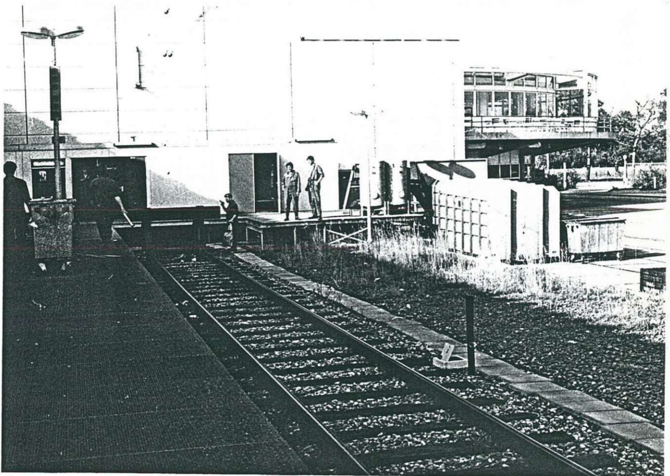
- magazijn en kantoor van de TECSO
