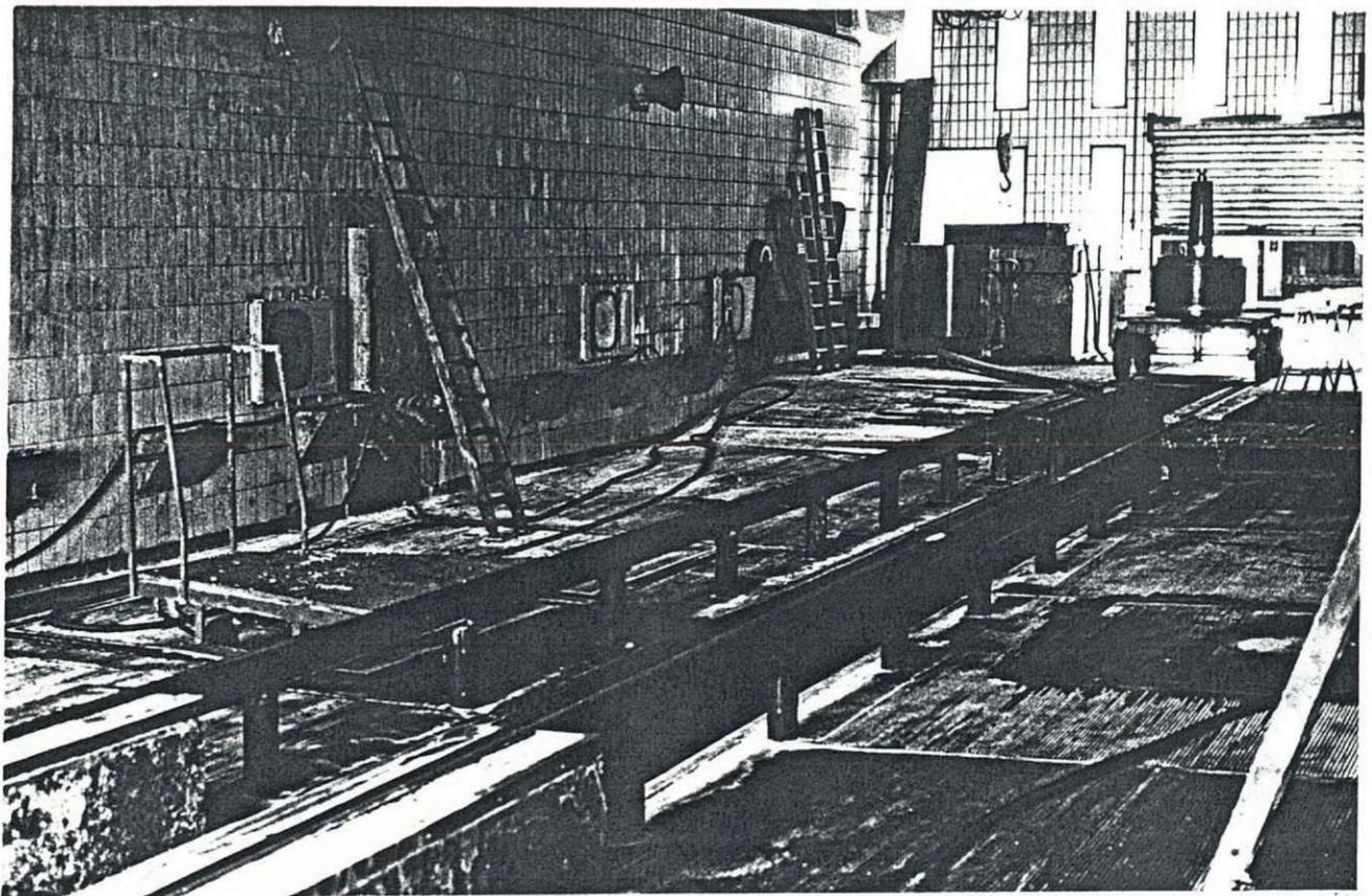
21. Hall de nettoyage des locomotives à la soude caustique. L'atelier est équipé depuis 1965 d'une installation de traitement des eaux.
