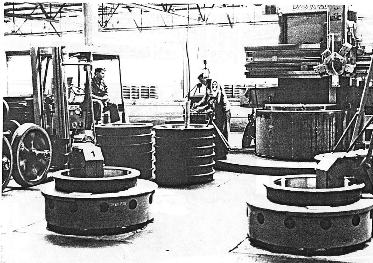
17 Chauffage par induction des bandages avant leur sertissage sur le corps de roue. Pour démonter le bandage du corps de roue on enlève son anneau de retenue et ensuite on le coupe
