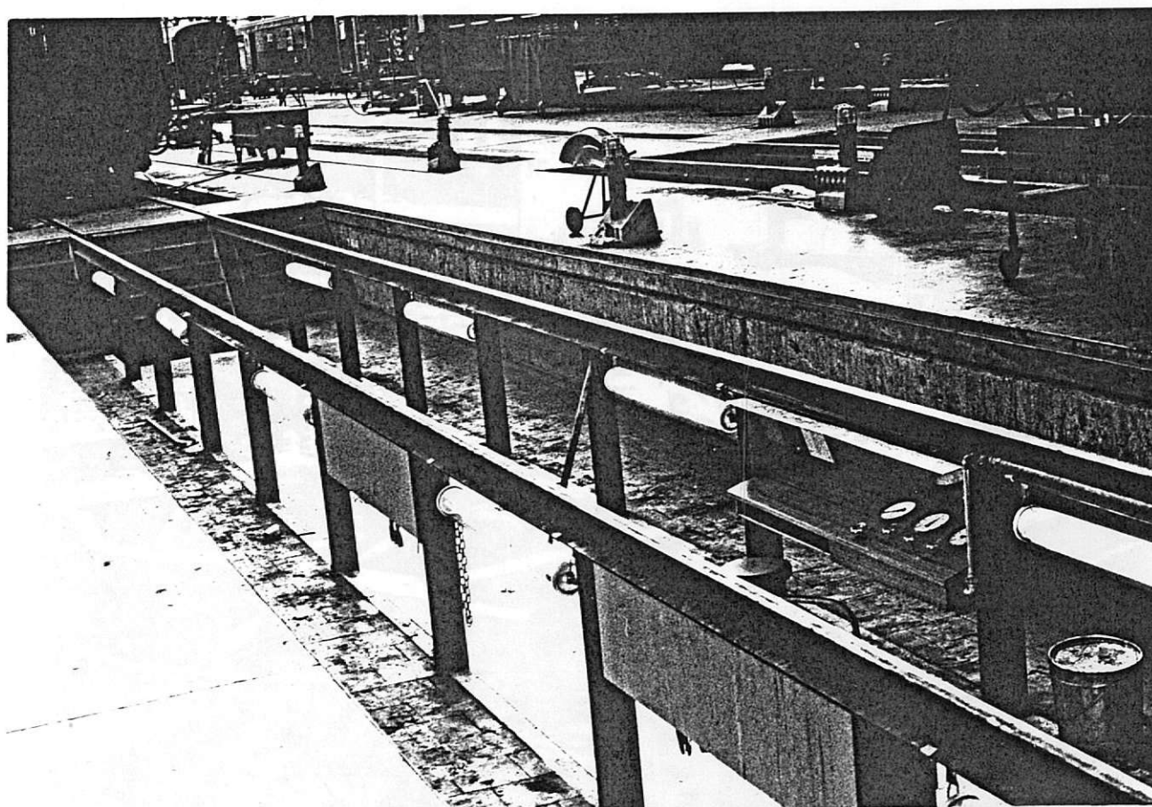
11 Stand de levage du châssis de bogie
