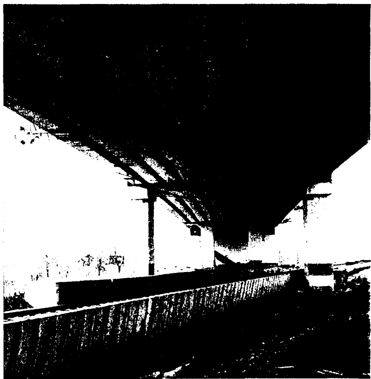
Op de voorgrond, de centrale pijler B, samengesteld uit twee palen en een dwarsbalk die de elf balken van de overbruggingen 2 en 3 ondersteunt; de twee sporen lopen, tussen twee perronmuurtjes, onder deze pijler door. In het midden, pijler A, waarvan de rechterpaal dicht bij een der sporen staat. Op de achtergrond het landhoofd, kant Nijvel.
