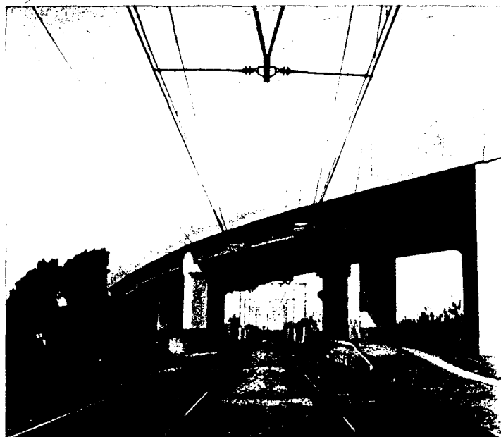
De foto die in het midden van de sporen werd genomen, doet de verschillende opstelling van de drie pijlers ten opzichte van de sporen uitkomen. Men bemerkt ook de inrichting om de bovenleidingen aan het brugdek vast te haken.
