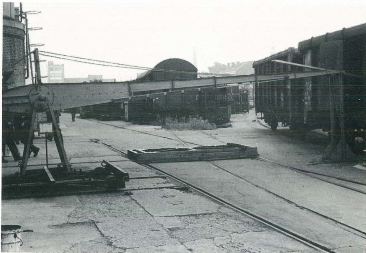
Fig. 28 Chemin de roulement mobile permettant de charger directement dans les wagons
