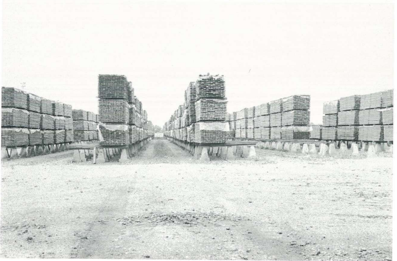
Fig. 20 Vue du chantier de séchage de Gand-Maritime
