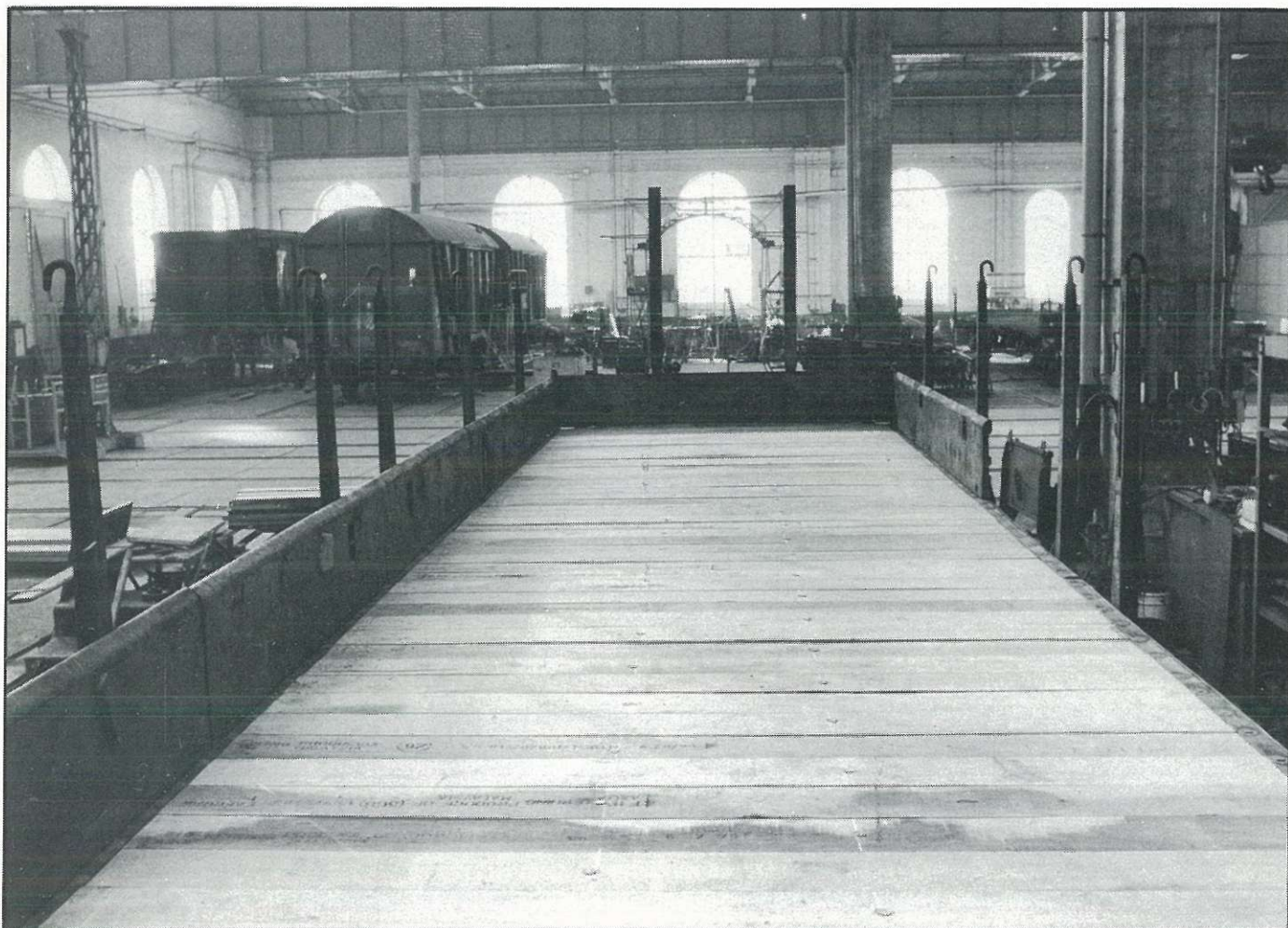
Fig. 41 Plancher après remise à neuf lors d'une grande révision
