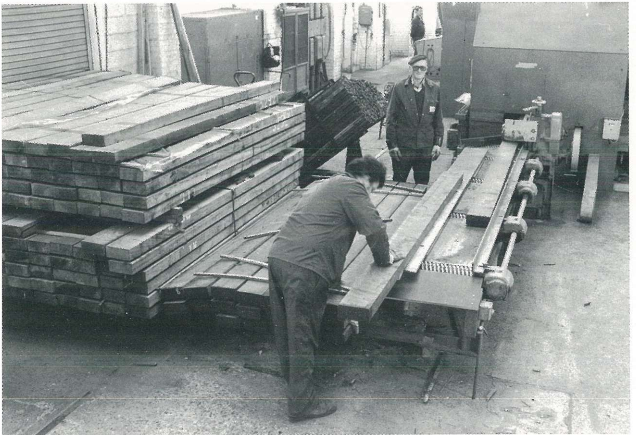
Fig. 22 Engagement des planches dans la quatre-faces
