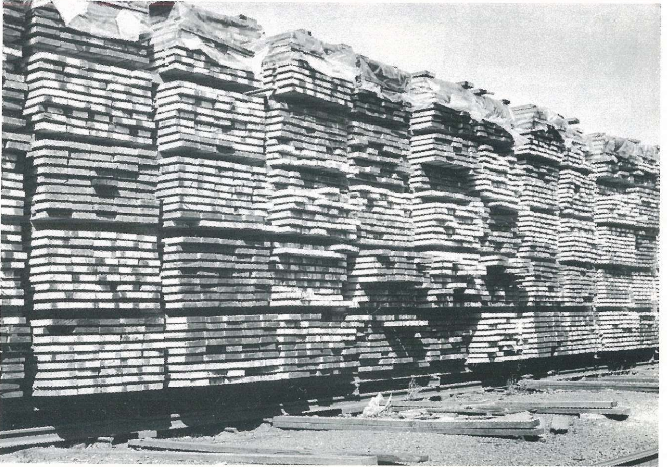
Fig. 31 Chantier de séchage des bois bruts à Cuesmes
