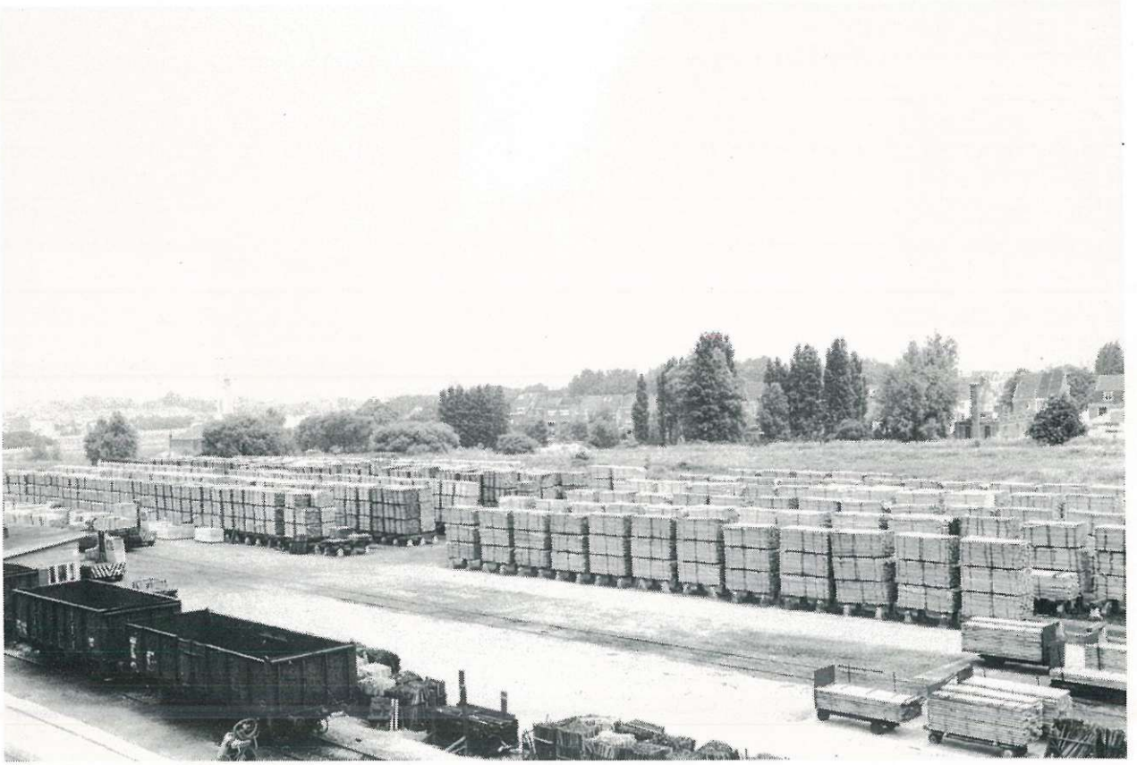
Fig. 21 Vue générale du chantier de séchage de Gand-Maritime.
