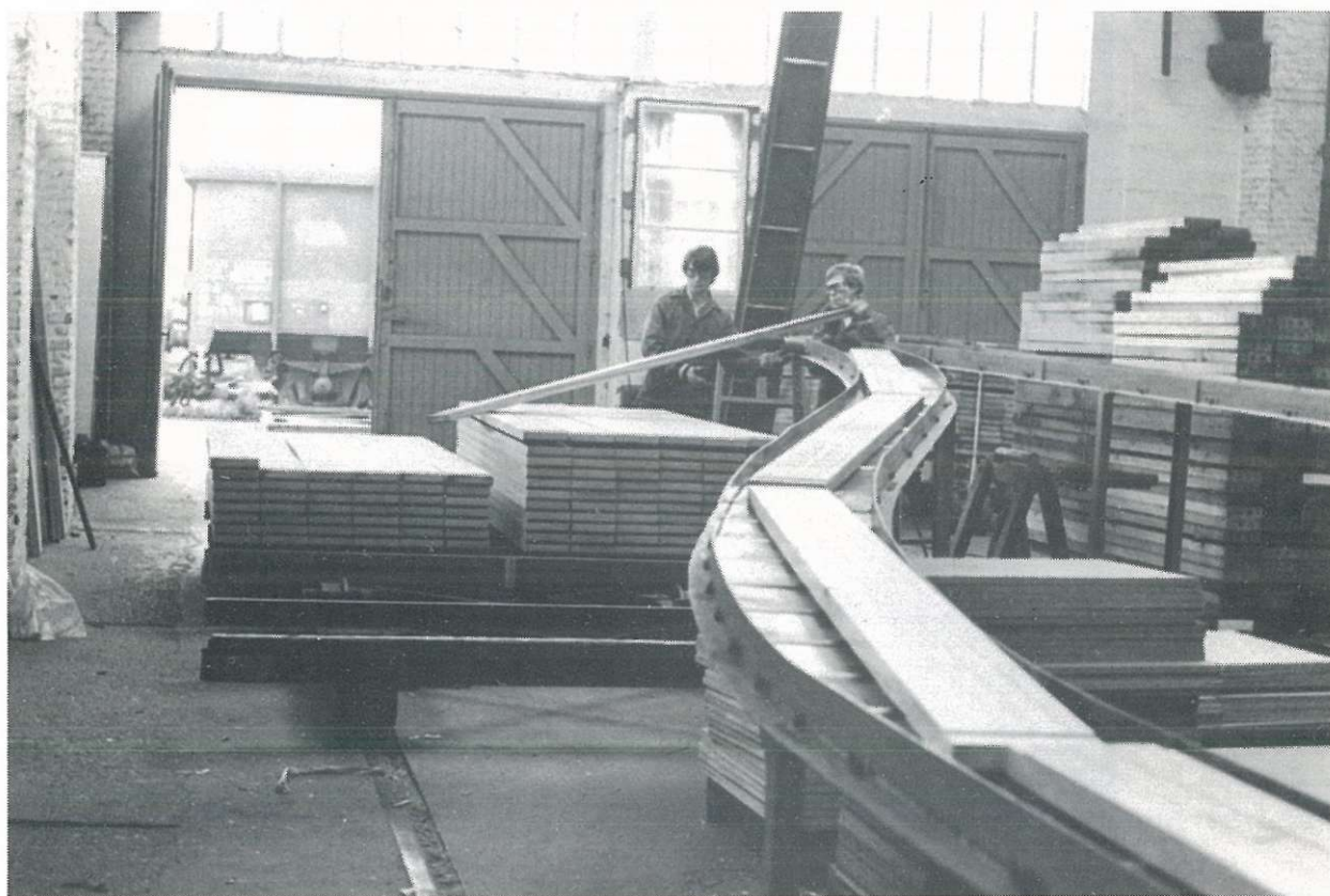
Fig. 26 Chemin de roulement amenant les planches à l'emplacement du classement
