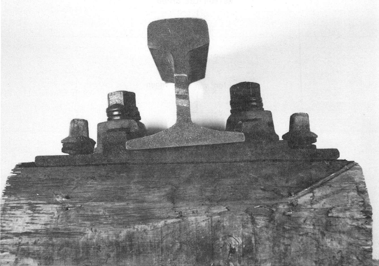
Fig. 6.1 Spoorstaafopstelling op een Angleurplaat met Vossloh-ringbevestigingen
