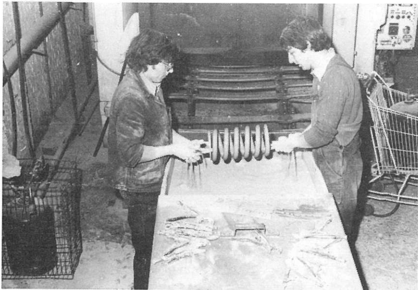
Fig. 7.5 Dompeling van de veer in het Rilsan-wervelsinterbad
