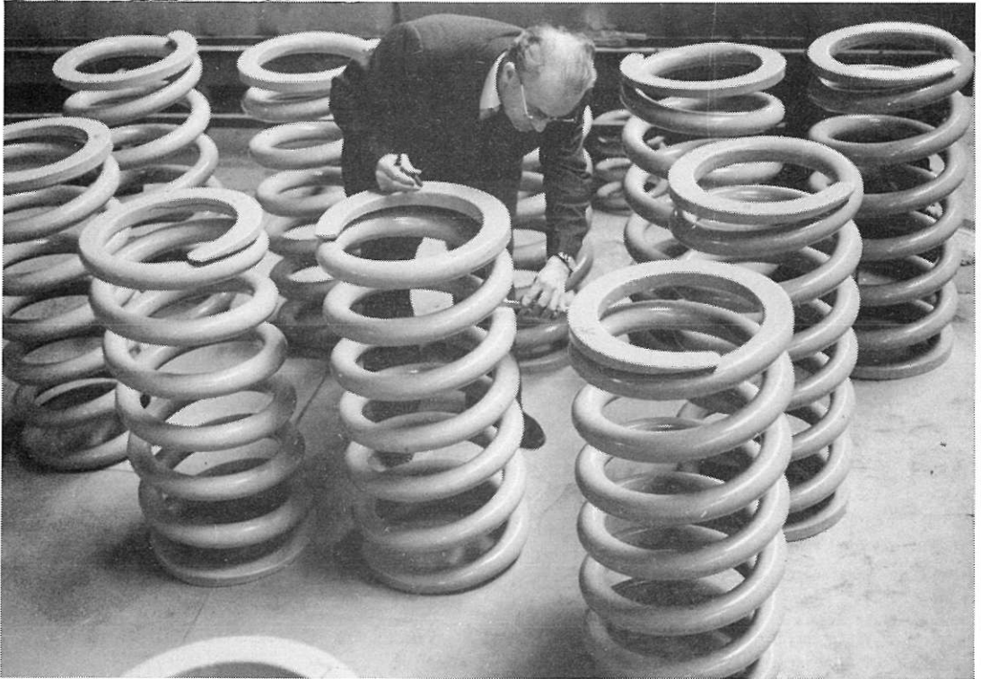
Fig. 1.19 Warmgevormde en gerilsaniseerde drukschroefveren voor Y-32 draaistel
