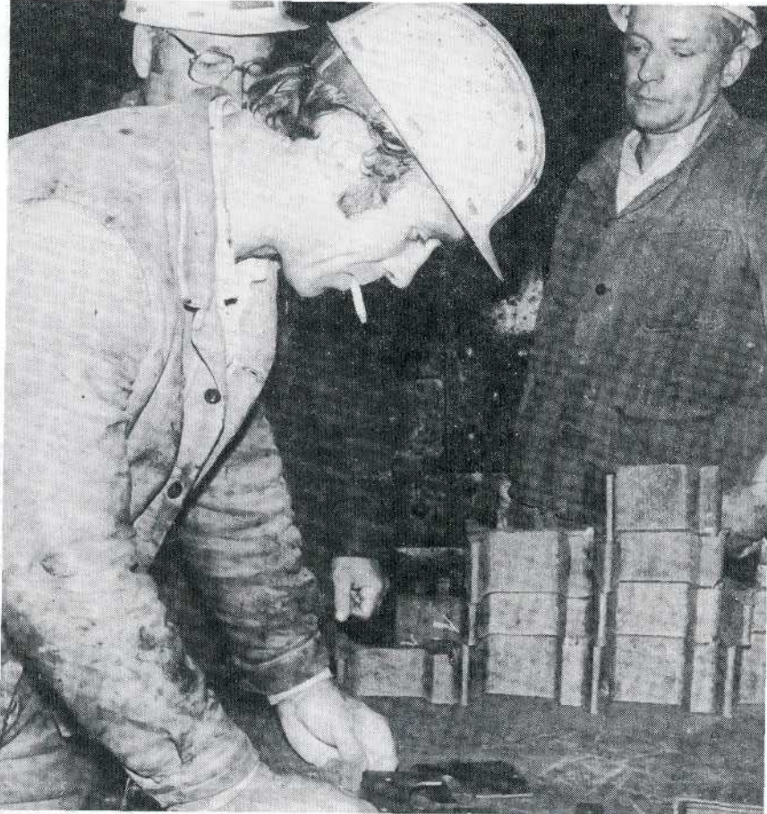
Figuur 7.1 Nazicht van de afmetingen van spoorstaafmonsters met de kalibers.
