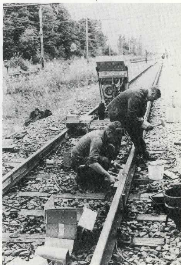
Figuur 8.18 Regeling van de voeghoogte en uitlijning met een liniaal.
