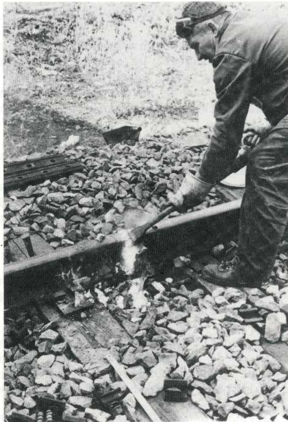
Figuur 8.32 Afsnijden van het overtollig metaal.
