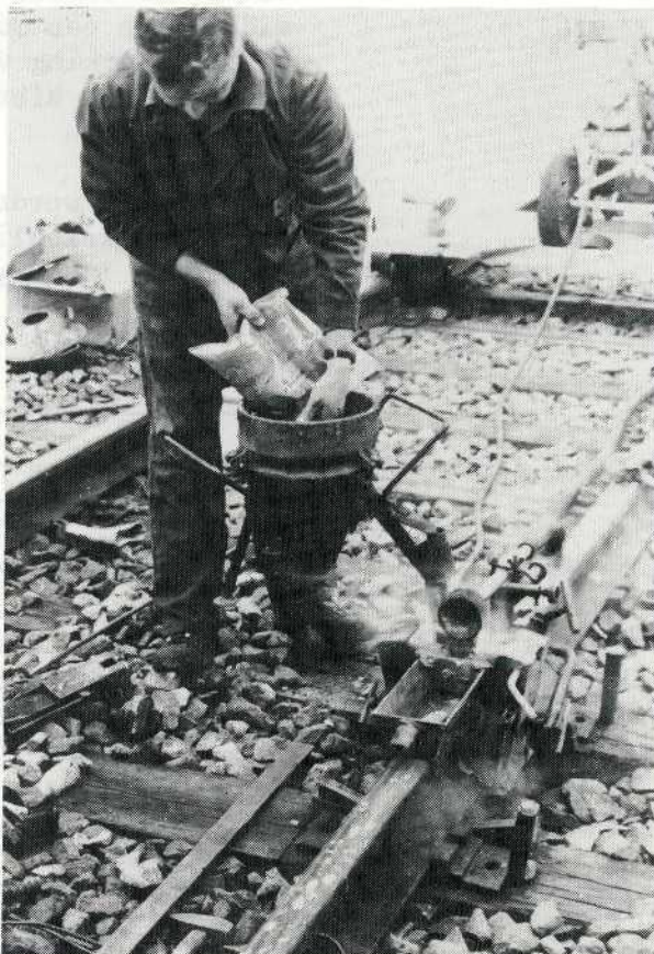
Figuur 8.26 Vullen van de kroes met de laspoederlading.
