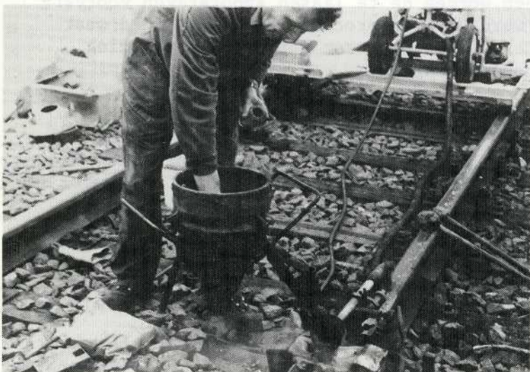
Figuur 8.25 Plaatsen van de afsluitingsstift op de bodemopening van de gietkroes.
