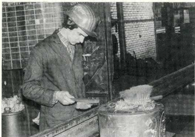
Figuur 7.2 Nazicht van het uitzicht van de spoorstaven na doorgang door de rollenrichtmachine.
