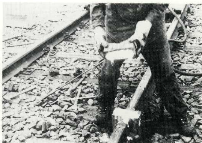
Figuur 8.31 Wegnemen van de gloeiende gietvorm.
