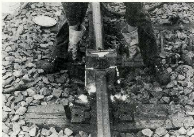
Figuur 8.30 Wegnemen van de gietvormhouders.
