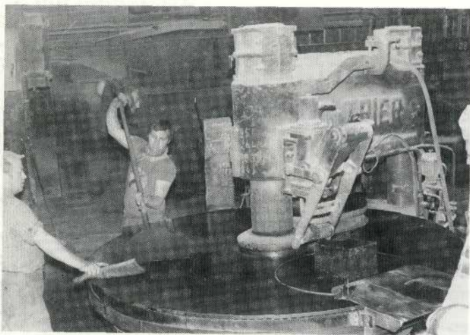
Figuur 4.23 Vervaardiging van vuurvaste stenen bestemd voor de bekleding van de convertor.
