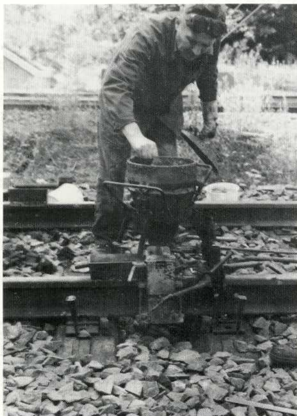
Figuur 8.27 Exothermische reactie in de kroes.
