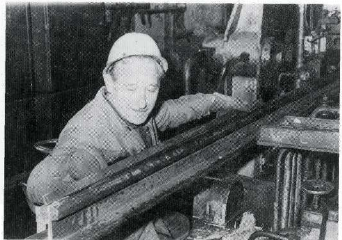
Figuur 6.4 Nazicht van de rechtlijnigheid van een spoorstaafuiteinde tijdens het richten.
