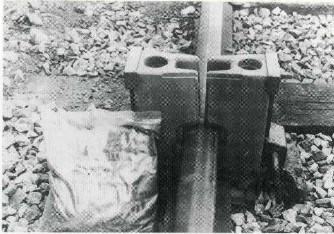
Figuur 8.19 Geprefabriceerde gietvorm en polyetyleen zakje met voorafbereide laspoederlading.
