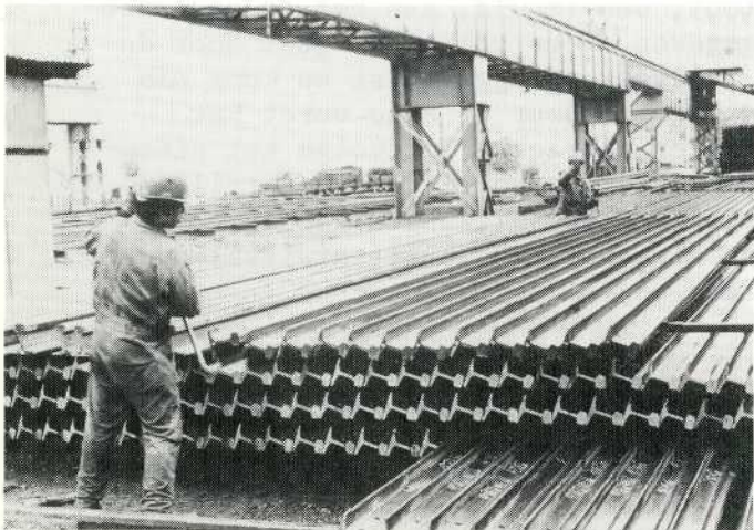
Figuur 7.8 Voorbereiding van de lagen rails voor het eindonderzoek (Villerupt).
