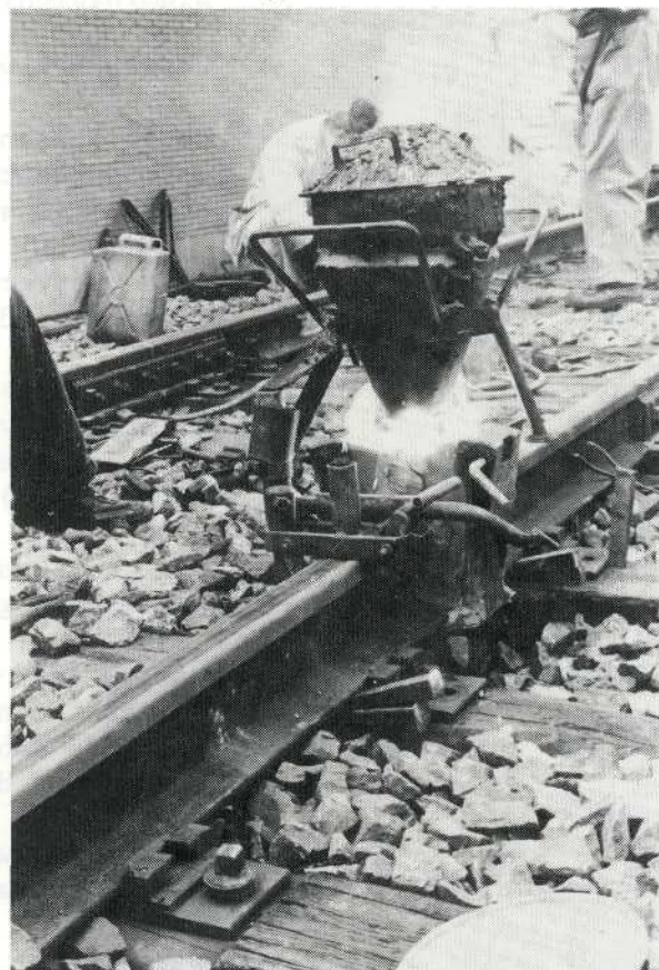
Figuur 8.28 Het gieten van de lasvoeg.
