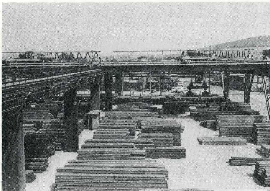
Le parc à blooms après les travaux.
