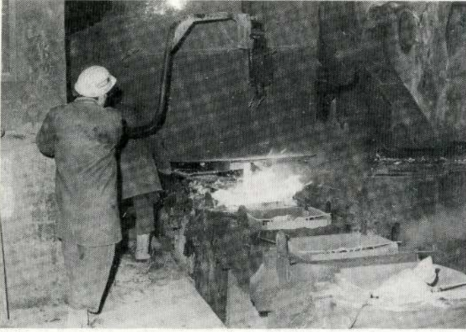
Figure 4.29 Coulée de l'acier en chute directe dans des lingotières masselottées.
