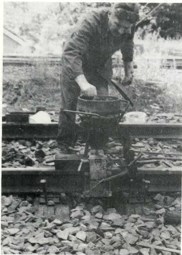
Figure 8.27 Réaction exothermique dans le creuset.
