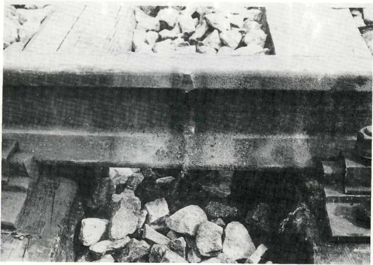
Figure 8.16 Soudure par étincelage en voie.
