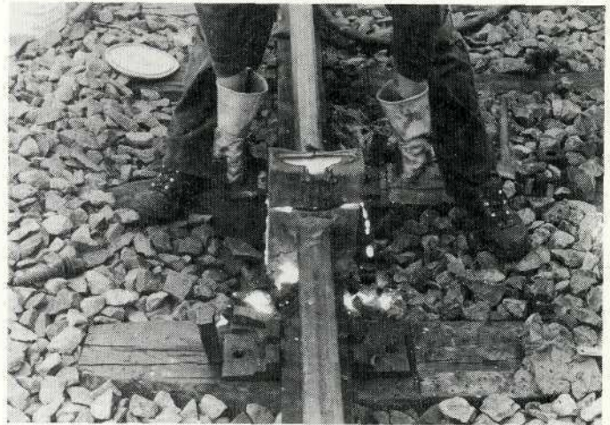
Figure 8.30 Enlèvement des carcasses.
