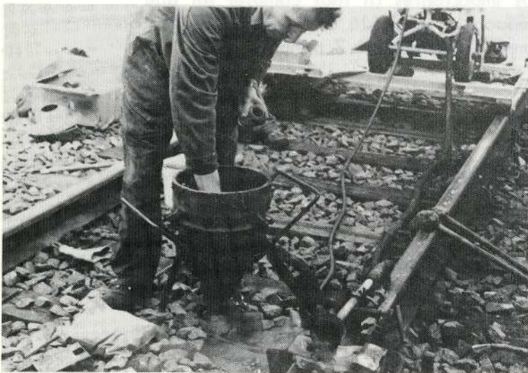
Figure 8.25 Obturation de l'orifice du creuset.
