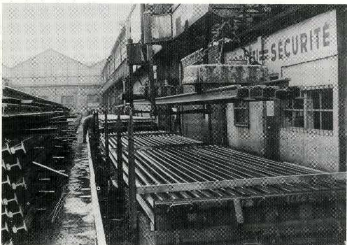
Figure 7.10 Rails en cours de chargement à Villerupt.
