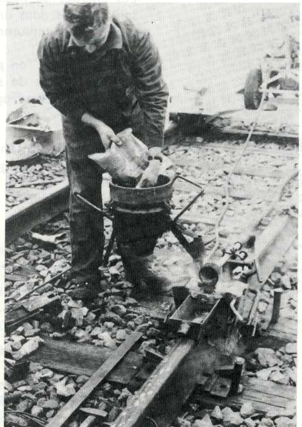
Figure 8.26 Remplissage du creuset avec la charge de soudure.
