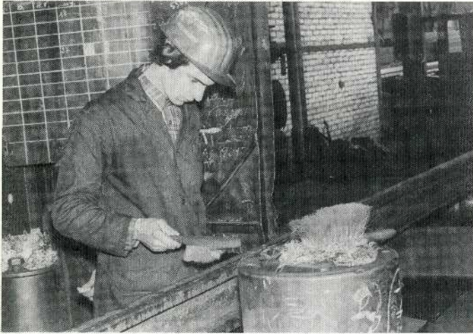
Figure 7.2 Vérification de l'aspect des rails à la sortie de la dresseuse.
