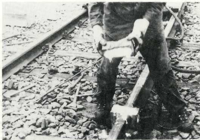
Figure 8.31 Enlèvement du moule incandescent.
