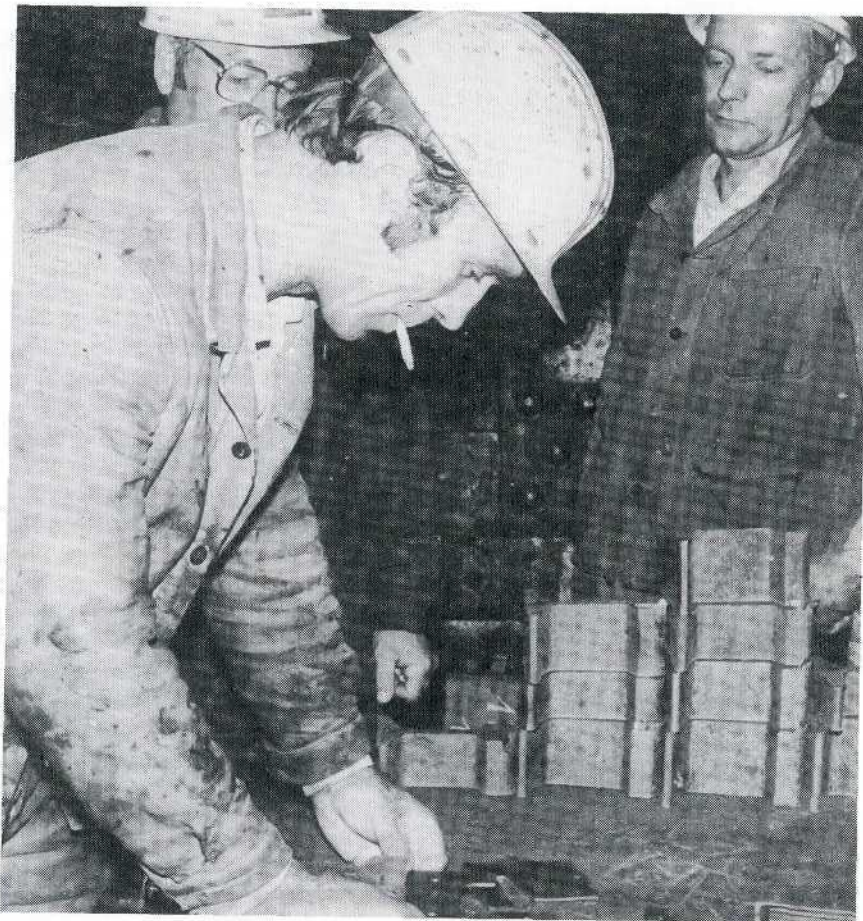
Figure 7.1 Vérification dimensionnelle de chandelles de rails prélevées au laminoir à l'aide de calibres.
