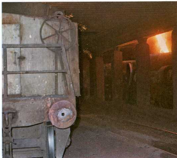
Poche de coulée de fonte (avant-plan) et coulée du laitier dans une poche à laitier (humpen).
