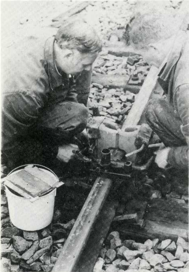
Figure 8.20 Fixation des moules dans la presse serremoule.
