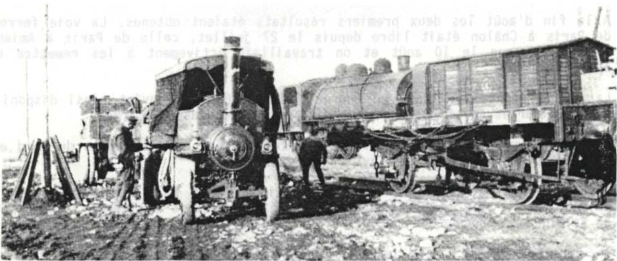
Vue d'une tête de ligne militaire près du front à Cattenières, dans le Nord de la France. A l'avant-plan une locomobile à vapeur Clayton, à droite un wagon plat et un fermé EB, à l'arrière une locomotive de manœuvre américaine type 2-6-2 ( futur type 57 ). La photo a été prise en septembre 1918 par M. Mc Nought, vétéran de la première guerre mondiale et publiée dans Railway World de mars 1969.
