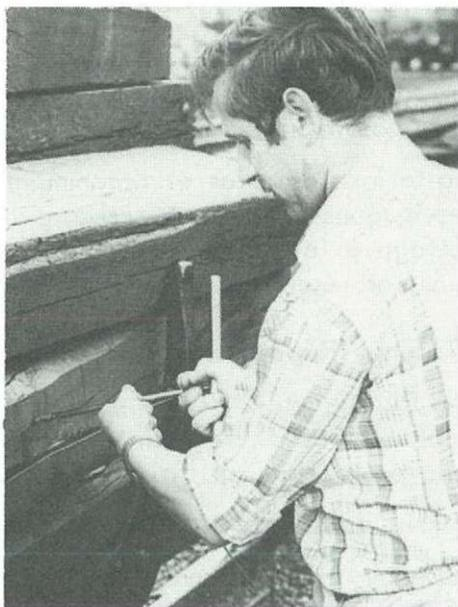
Fig. 49 Extraction de carottes hors des traverses créosotées.
