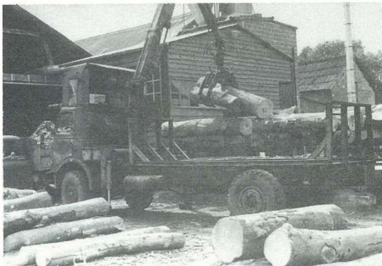
Fig. 14 Etalage des billes sur l'aire d'attente devant l'écorceuse.
