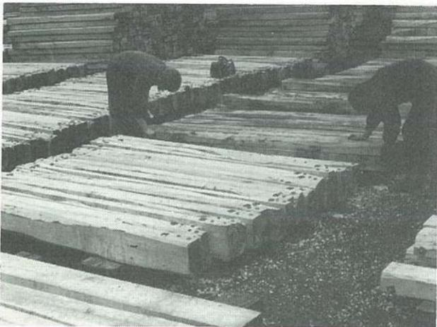
Fig. 26 Placement des boulons de serrage.
