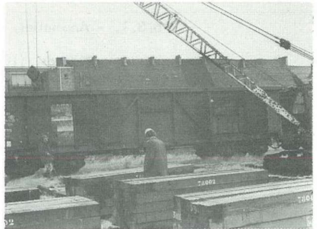
Fig. 19 Déchargement à la grue d'un wagon chargé de traverses en Azobé.
