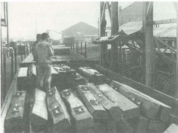
Fig. 55 Chargement des traverses munies de leurs accessoires sur wagon.
