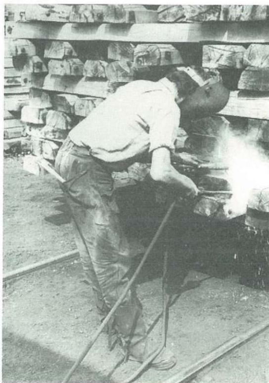
Fig. 34 Découpage à l'arc des tiges des boulons qui dépassent.
