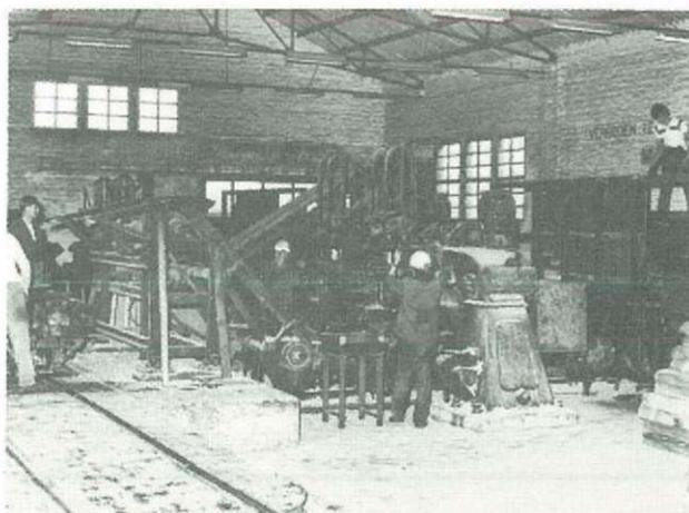
fig. 36 Entailleuse perceuse de traverses au travail.
