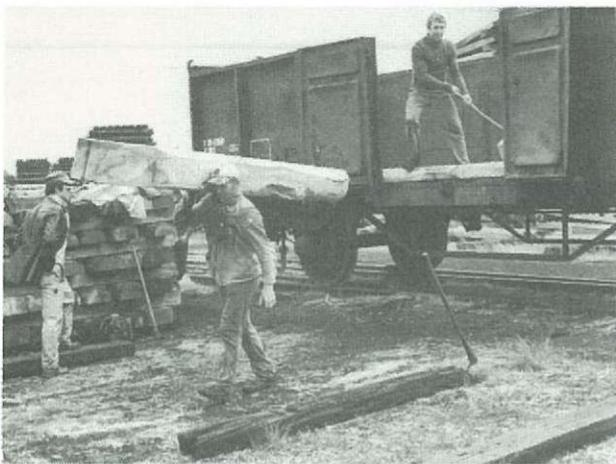
Fig. 20 Déchargement manuel de traverses.
