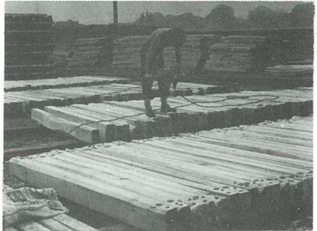
Fig. 25 Forage des extrémités des traverses en hêtre.
