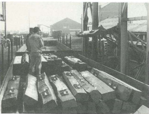
Fig. 55 Laden van de volledig uitgeruste dwarsliggers op spoorwagens.
