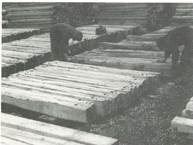
Fig. 26 Plaatsing van aansluitbouten.
