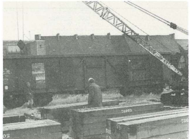
Fig. 19 Lossen met de kraan van een wagen geladen met azobe draagstukken.
