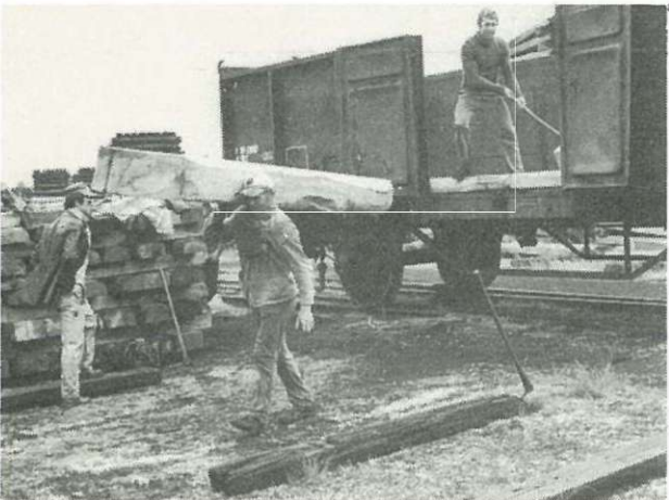
Fig. 20 Lossen met de hand van draagstukken.
