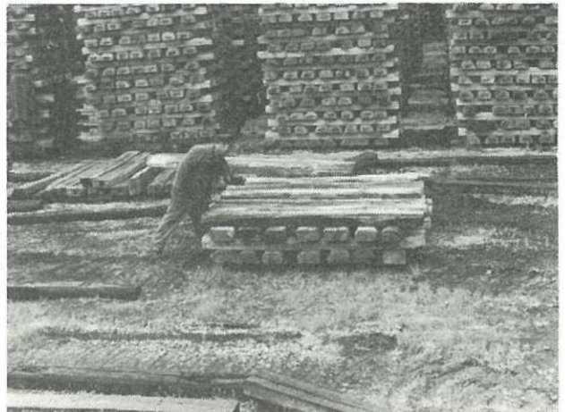
Fig. 21 Voorlopig stapelen in open stapeltjes.
