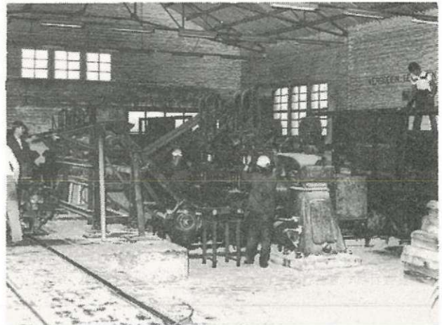
Fig. 36 Inkeep- en boormachine voor dwarsliggers in werking.
