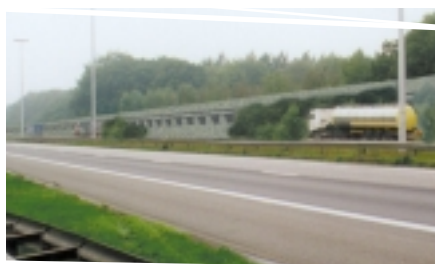
Tussen de Kleine Bareel en de Elshoutbaan in Schoten ligt de hsl in een koker met opengewerkte wand naar de E19.
