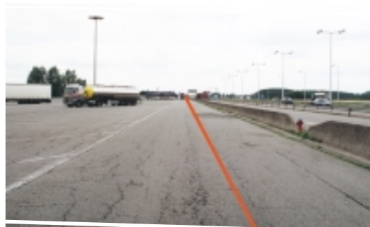
Het gebied van de serviceparking Minderhout wordt uitgebreid en zal 3 meter boven het niveau van de E19 worden aangelegd.
