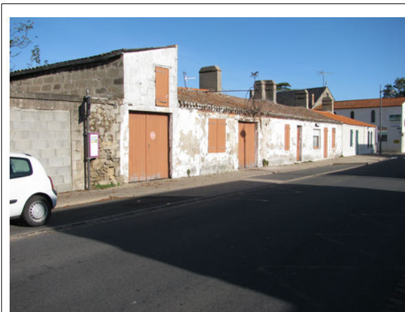
Illustration 17: ligne routière régionale Nantes-Noirmoutier- arrêt sur la commune de Bouin – source : photo CETE Ouest
