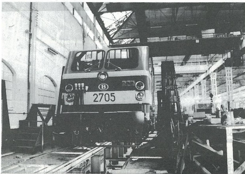
De locomotief krijgt vorm op de montageband.
