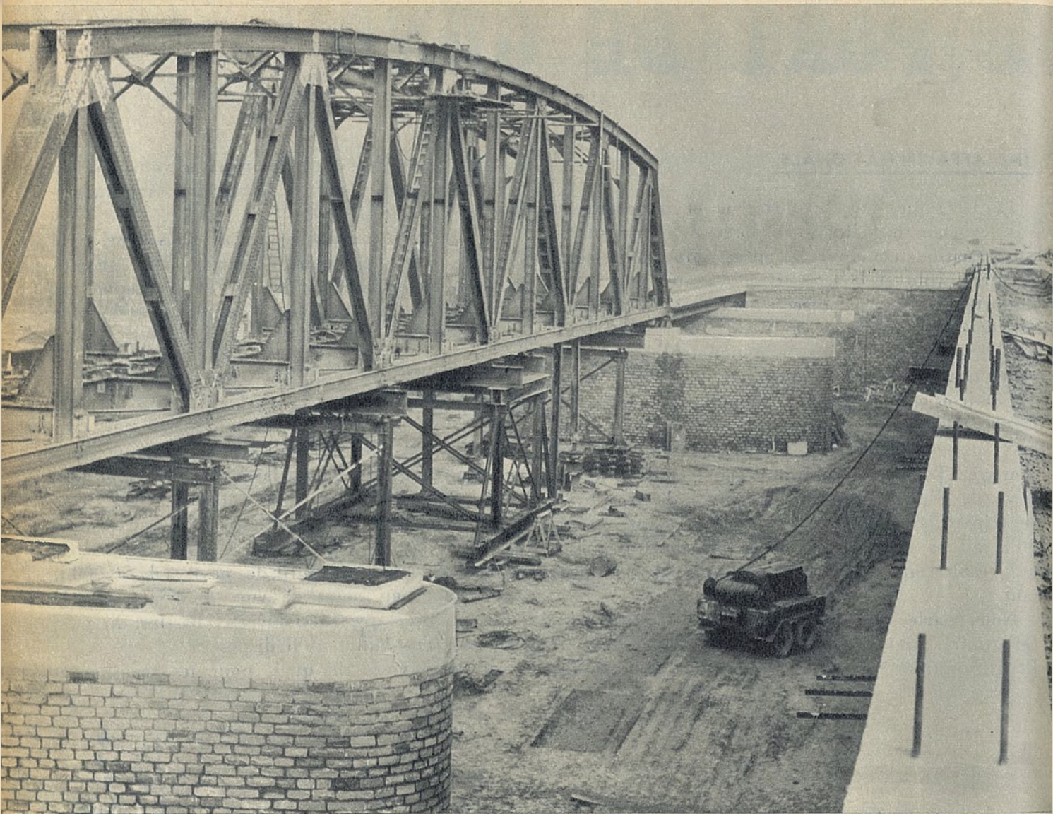
Le pont ferroviaire sur le nouveau tracé du Moervaart.
