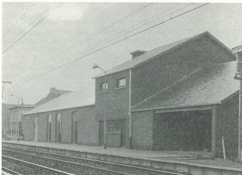
... et le nouveau bâtiment à voyageurs, sobre et fonctionnel.
