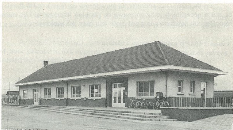
Un bâtiment frais et pimpant pour accueillir les voyageurs à Blaton.
