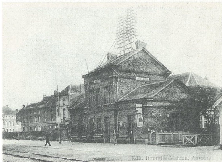
L'ancienne gare d'Antoing achevée en 1914 ...
