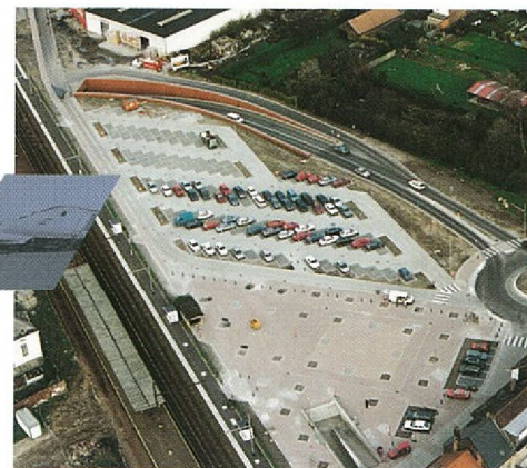
stopplaats Ruisbroek: een mooi voorbeeld van modernisering
