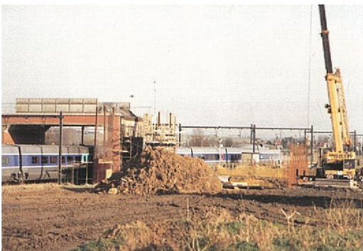
erken langs de bestaande spoorlijn
