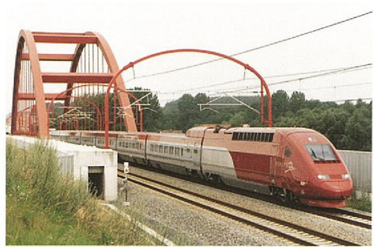
het viaduct van Antoing
