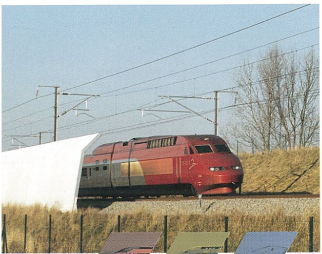
geluidswerende wand langs de hsl
