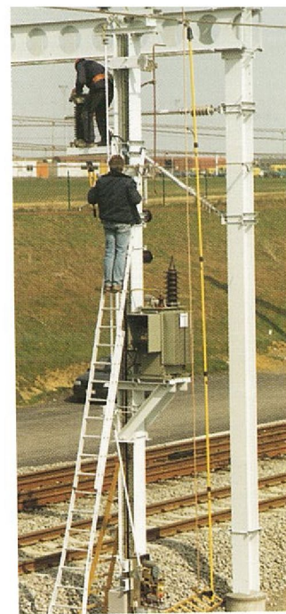
Werken voor de elektrificatie
