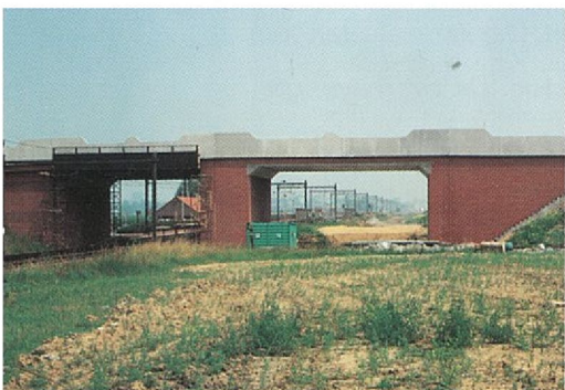
n voorbeeld van de verlenging van een brug in Silly
