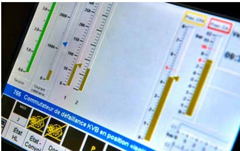
Affichage de l'énergie dans le poste de conduite d'une locomotive Type 18/19. Lorsque les indicateurs au-dessus des numéros 1 et 2 sont de couleur ocre, cela signifie que de l'énergie de freinage est récupérée et envoyée à la caténaire.
