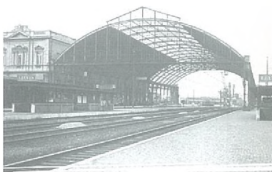
De oude perronoverkapping werd in '52 afgebroken.
