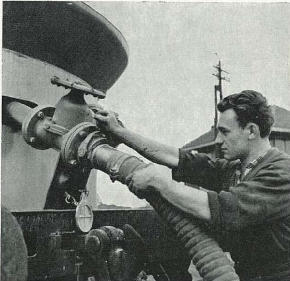
De buigzame leiding voor cement wordt op de wagen aangesloten.
