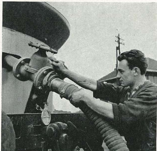
La conduite flexible pour le ciment est reliée au wagon.
