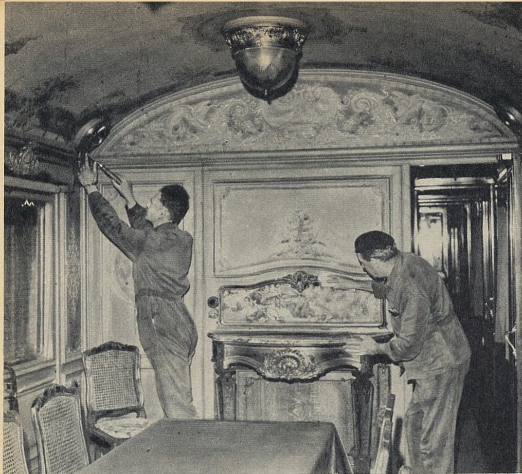
Binnenaanzicht van een rijtuig van de koninklijke trein van Leopold II tijdens de voltooiing van de restauratiewerken in de C.W. Mechelen.
