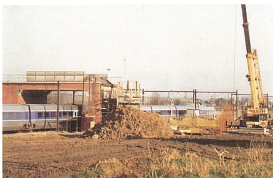
Travaux le long de la ligne classique
