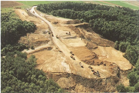
Site des 5 Rocs à Calonne en travaux
