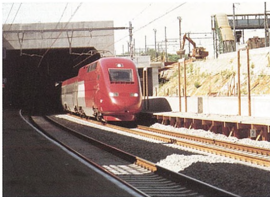
7 Tranchée couverte de Hal
