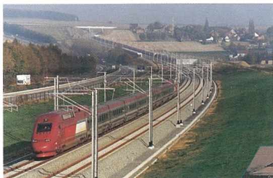
La LGV le long de l'autoroute A8 à Rebecq
