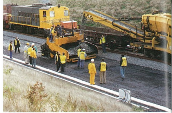
Pose de voies
