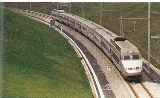
Courbe de raccordement de la LGV à la ligne 78 à Antoing
