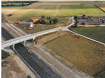
UN EXEMPLE DE PONT ROUTIER SUR LES 10 PREMIERS KM.
