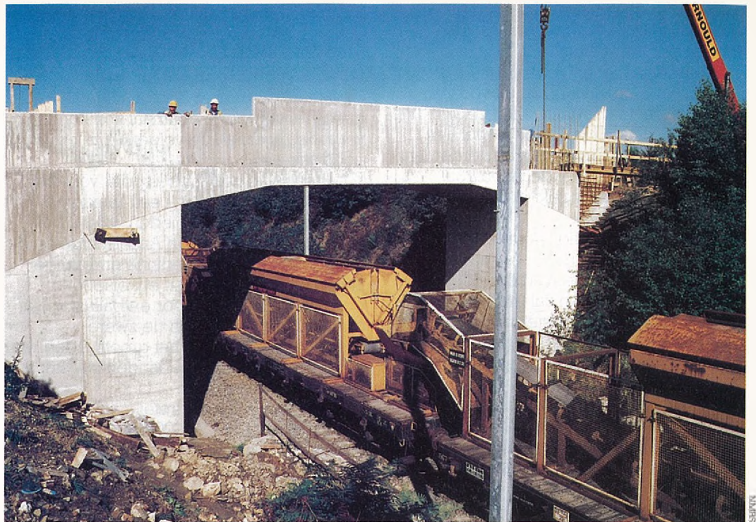
PLAATSING PALEN VOOR DE BOVENLEIDING
