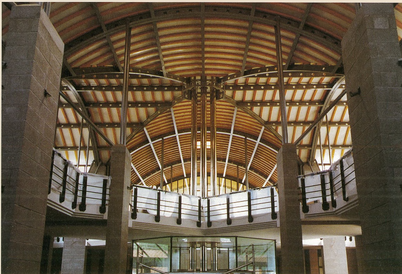
LE PLAFOND VISIBLE DEPUIS LE REZ-DE-CHAUSSÉE
