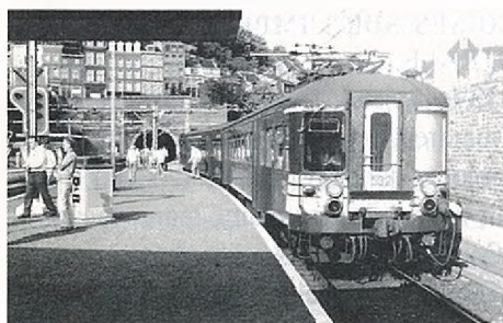
▼ Vue du tunnel de Pierreuse
