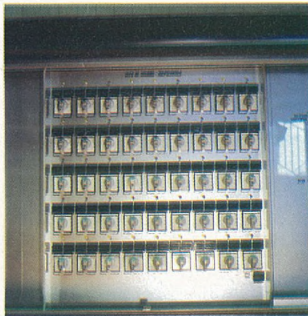
Kast met nood sleutels voorzien van lichtgevende diodes
