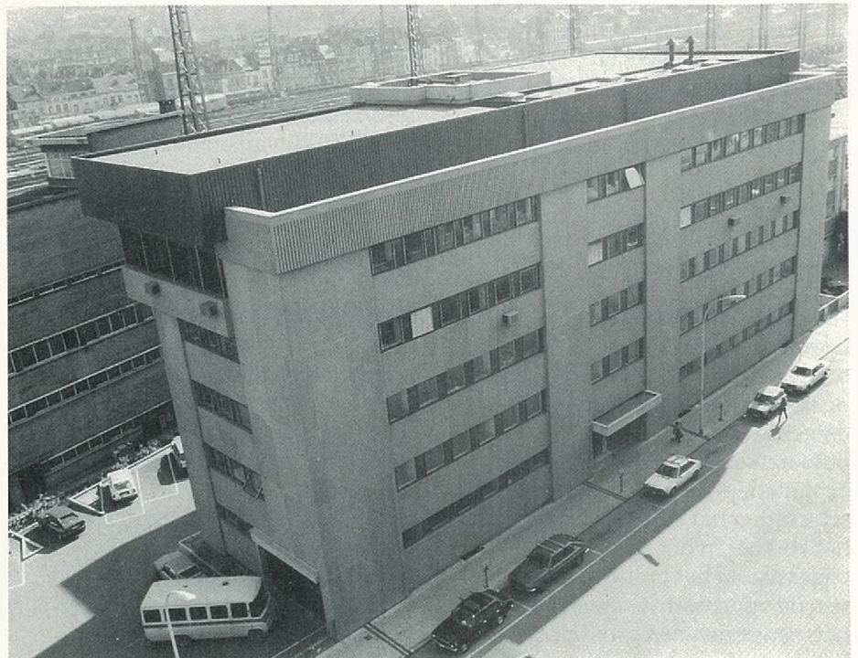
Het nieuwe seinhuis aan de Frankrijkstraat
