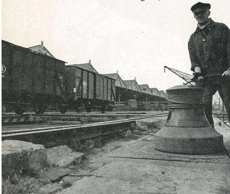
Kaapstander voor het bedienen der overzetbrug.
