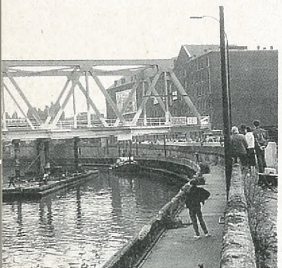
DE VOORTVLIEDENDE SAMBER TERWIJL DE BRUG GEPLAATST WORDT.
