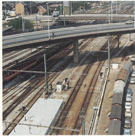
Een «luchtfoto» van de spoor- en weginfrastructuur, kant Brussel
