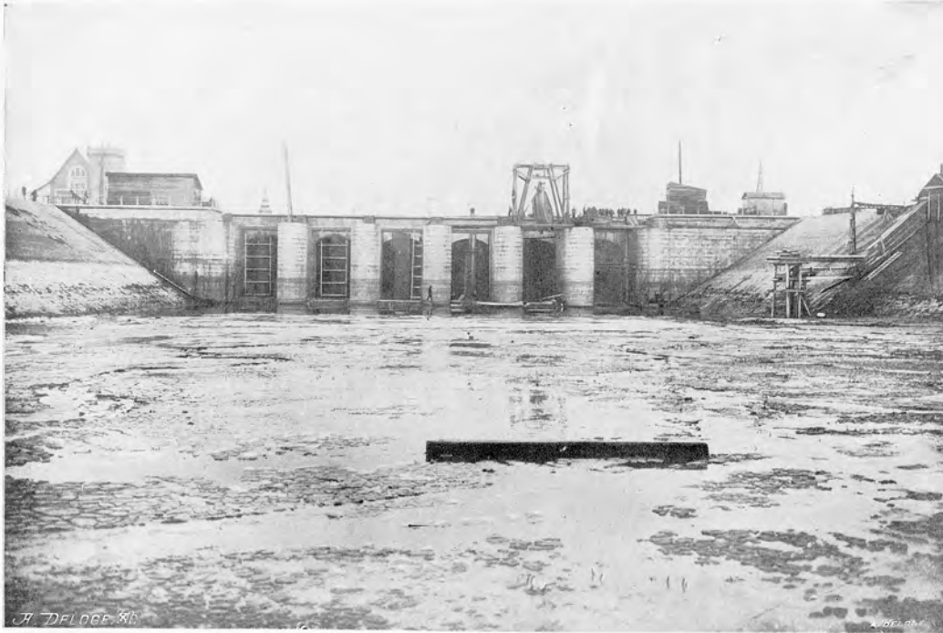
Portes de chasse dans les pertuis de la nouvelle écluse de chasse
