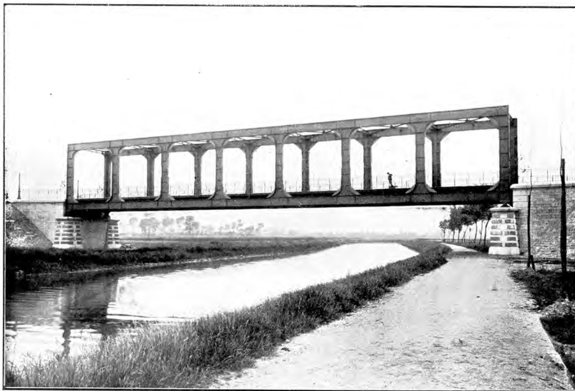
Pont à arcades syst. Vierendeel, de 42 m de portée, établi sur l'Escaut, entre Avelghem et Ruyen (Belgique)
