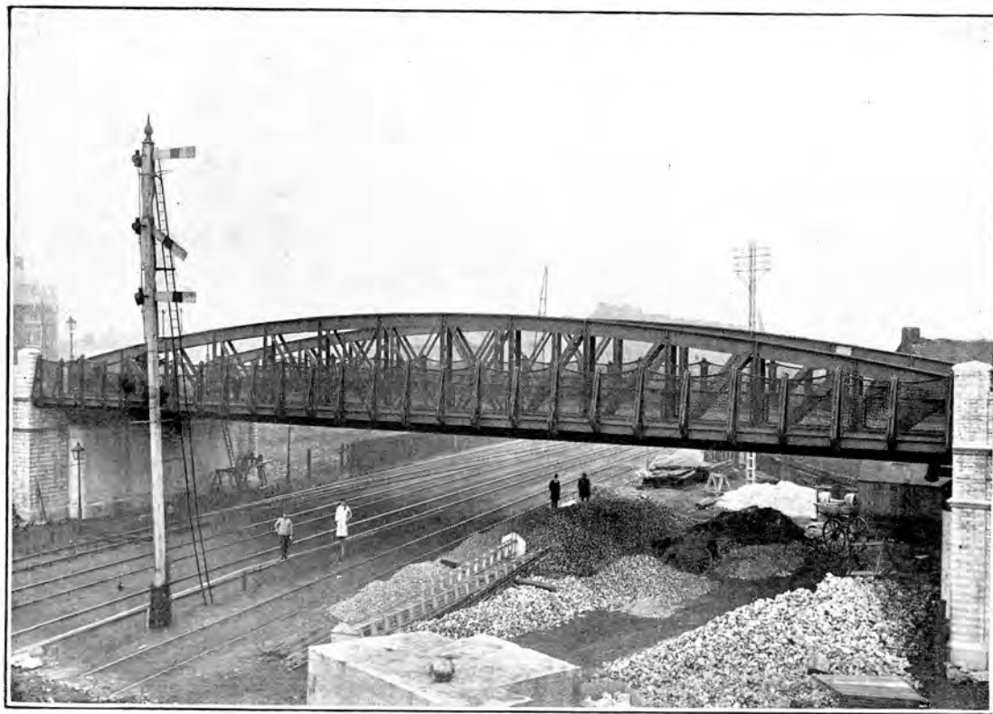
Viaduc supérieur Pont de la Villette, à Charleroi
