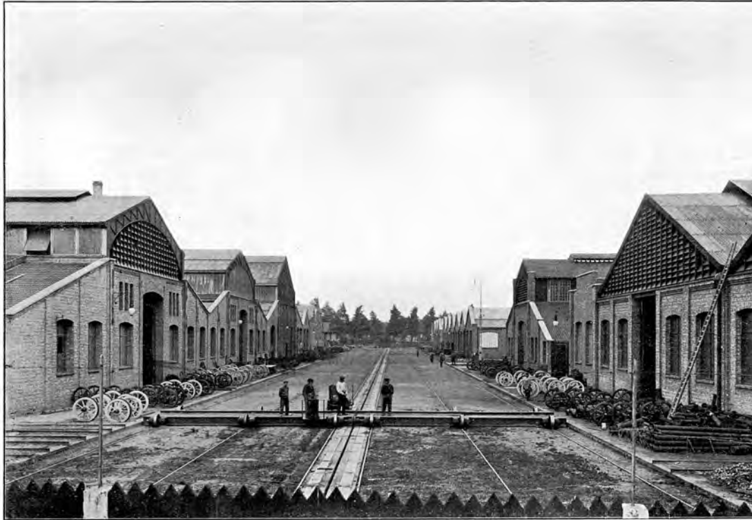
Vue du transbordeur central électrique. Longueur du parcours : 400 mètres
