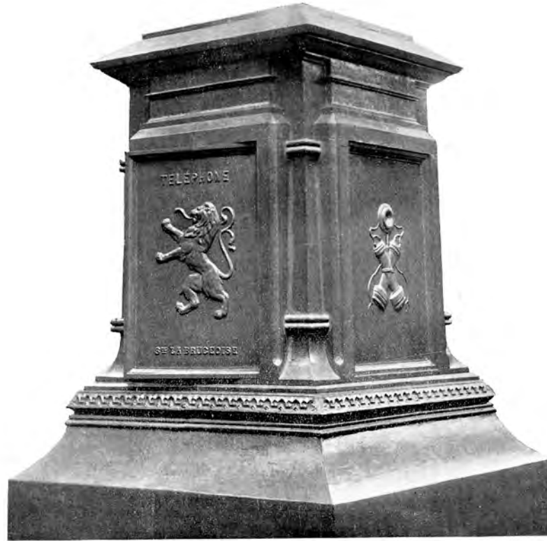
Soubassement en fonte pour les poteaux téléphoniques des villes de Gand et de Liège
