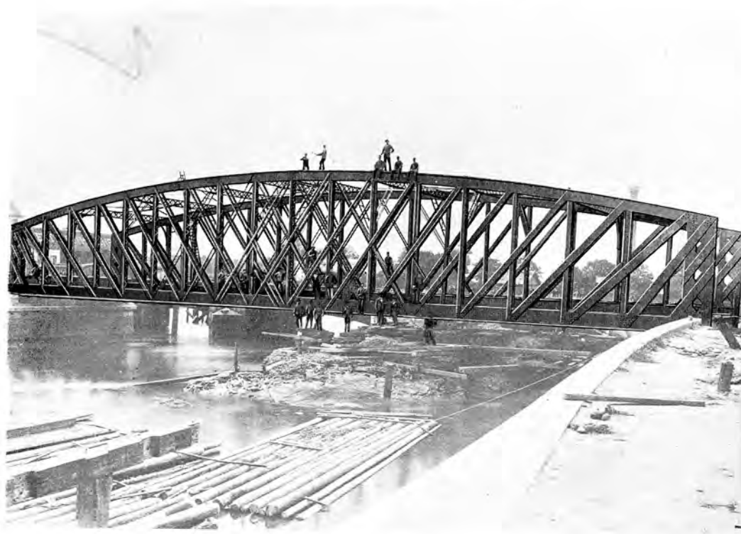
Pont sur la Dendre à Termonde (Belgique)
