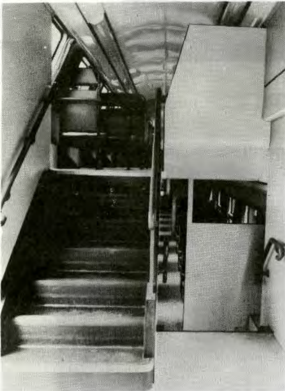
Vue des escaliers donnant accès aux étages supérieurs et inférieurs.
