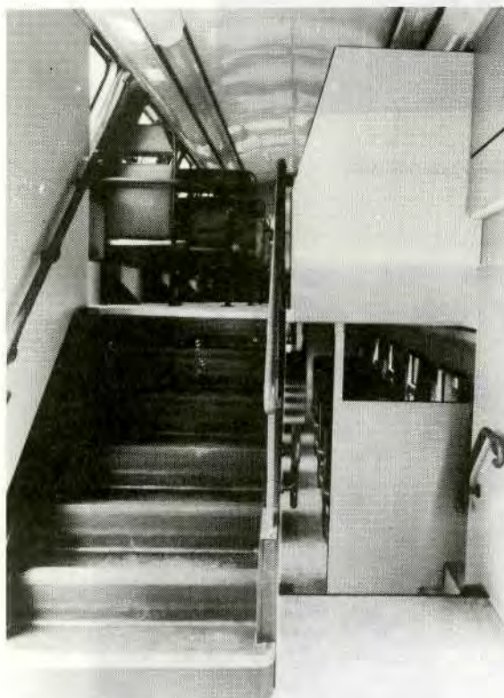
Zicht van de trappen die tot de bovenste en onderste verdieping toegang verlenen.
