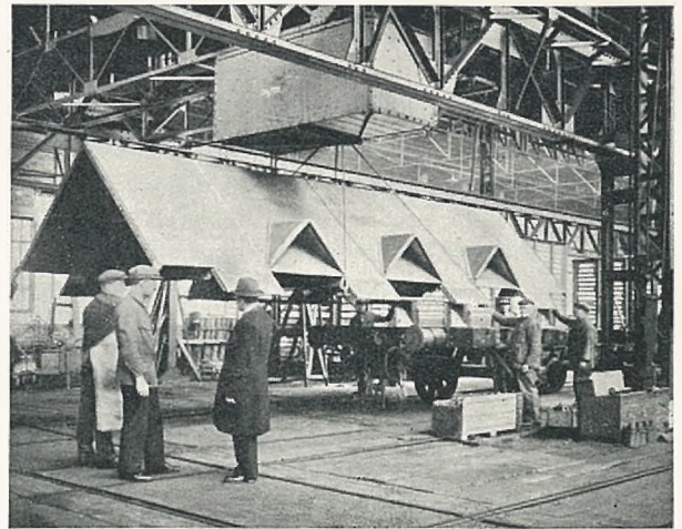
Fig. 30. — Montage des dos d'ânes de wagons-trémies.
