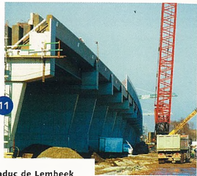
le viaduc de Lembeek
