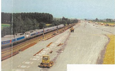
construction de la LGV le long de la ligne classique 94
