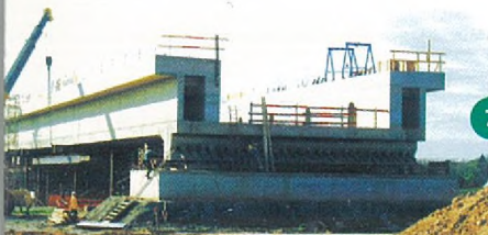
le viaduc d'Arbre
