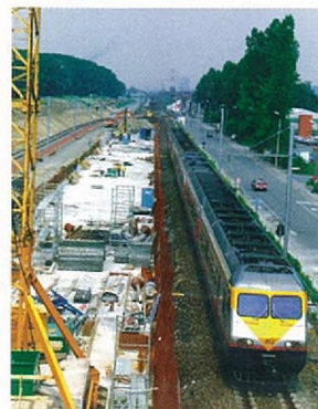
le viaduc de Lot
