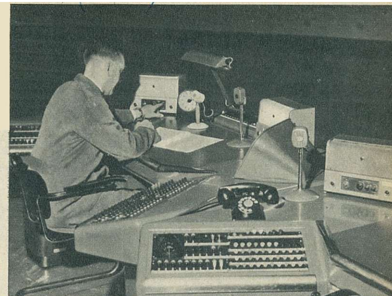
L'installation radio sur le pupitre du répartiteur E. S. de Bruxelles. On distingue les trois postes opérateurs avec leur micro.
