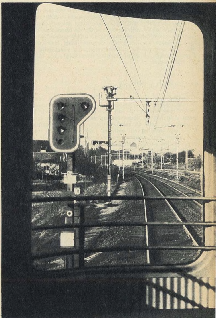
Het bloksein is van essentieel belang voor de regelmatigheid en de verkeersmogelijkheden der treinen.
