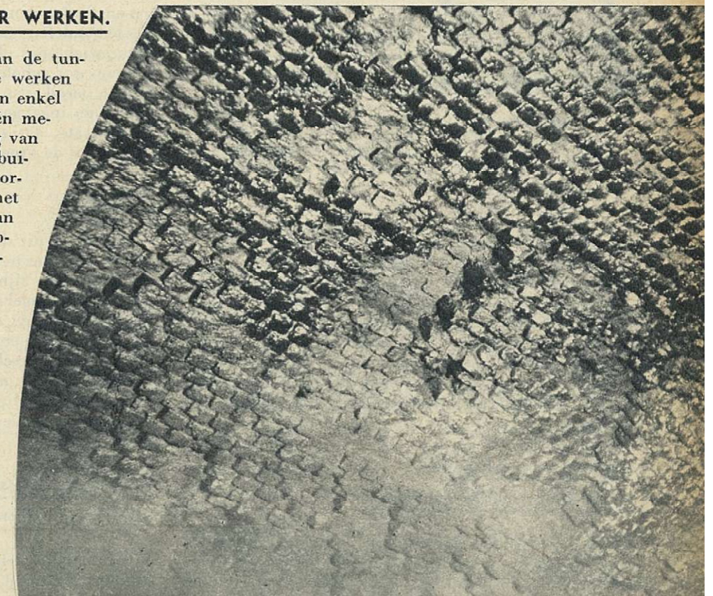
ZO ZAG DE BEKLEDING VAN DE TUNNELS ER UIT IN DE VOCHTIGE ZONES.
