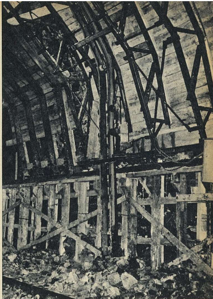
LINKS, DE BESCHERMINGSYLOER. IN HET MIDDEN, DE ELEVATOR VOOR HET AANBRENGEN DER WELFSTENEN. RECHTS, DE GEWELFFORMELEN.
