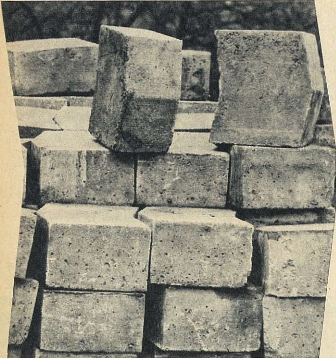
DE BETONNEN GEPREFABRICEEERDE WELFSTENEN. BEMERK VOORAL DE SCHUINE VORM DIE DE ONDERLINGE VERBINDING DER BEKLEDINGSRINGEN BEVORDERT.
