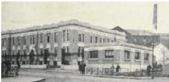
13: Ingang van fabriek I -ook nu nog de hoofdvestiging- met trasporen op de voorgrond.
