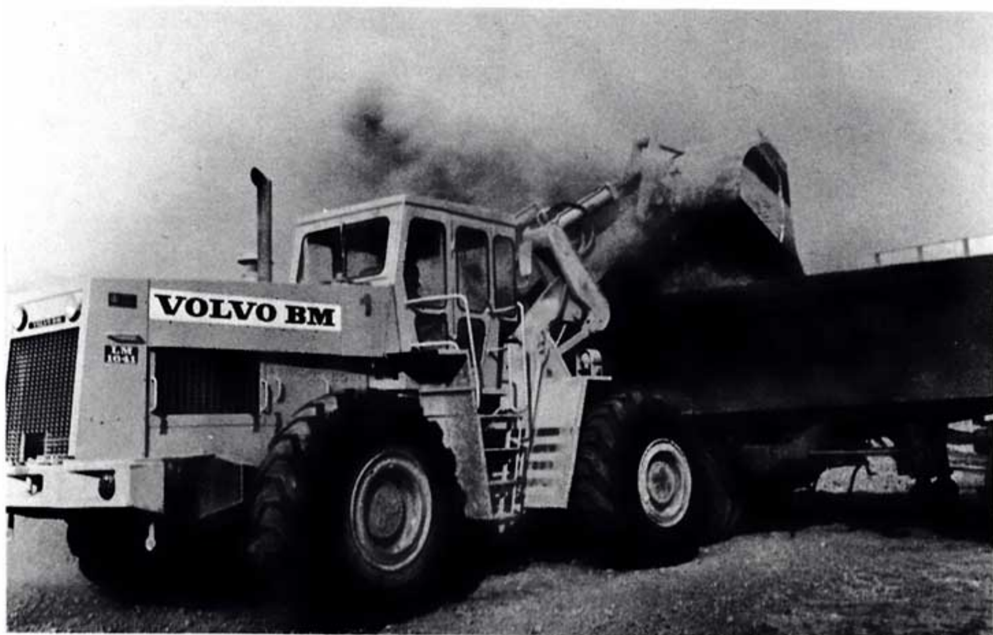
1e fase : mechanische schoppen laden de vrachtauto's.
