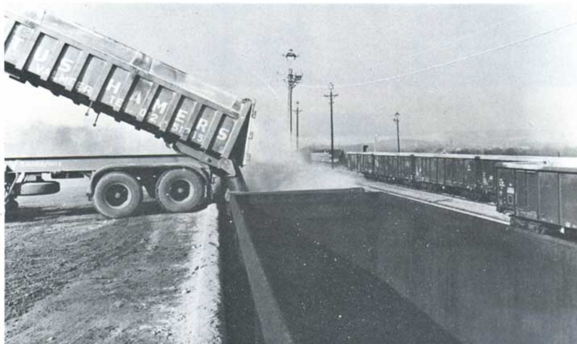
2e temps : Grâce à une butte ou à un quai surélevé, ils « bennent » la marchandise dans les wagons.
