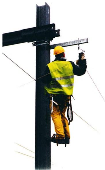
service est touchée et qu'elle ne fonctionne plus, la réparation au moins provisoire sera réalisée endéans les huit heures afin de permettre à nouveau un fonctionnement normal de la ligne. En cas peu probable de rupture totale d'un câble, l'effet de la rupture sur les sollicitations sur les poteaux ne se fera déjà plus sentir après le 3ème poteau grâce au système de sertissage du câble qui lui donne une force de glissement de 100 kg.
